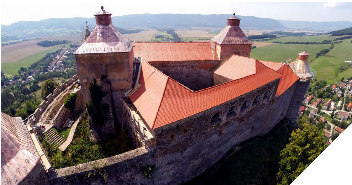
Rekonštrukcia strechy hradu Krásna hôrka - Viedenská škridla hranatá, prírodná.
