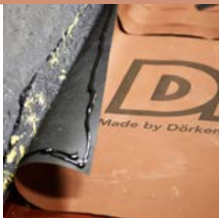
Detail napojenia fólie
